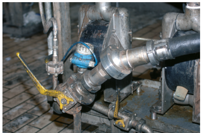
Abbildung 13b: Verlegen von Schlauchleitungen – Kugeldrehgelenk
